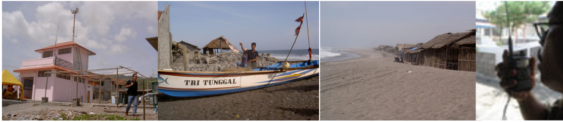
Di Pantai Selatan Jawa, sistem peringatan sirine sudah dipasang di Kabupaten Bantul
